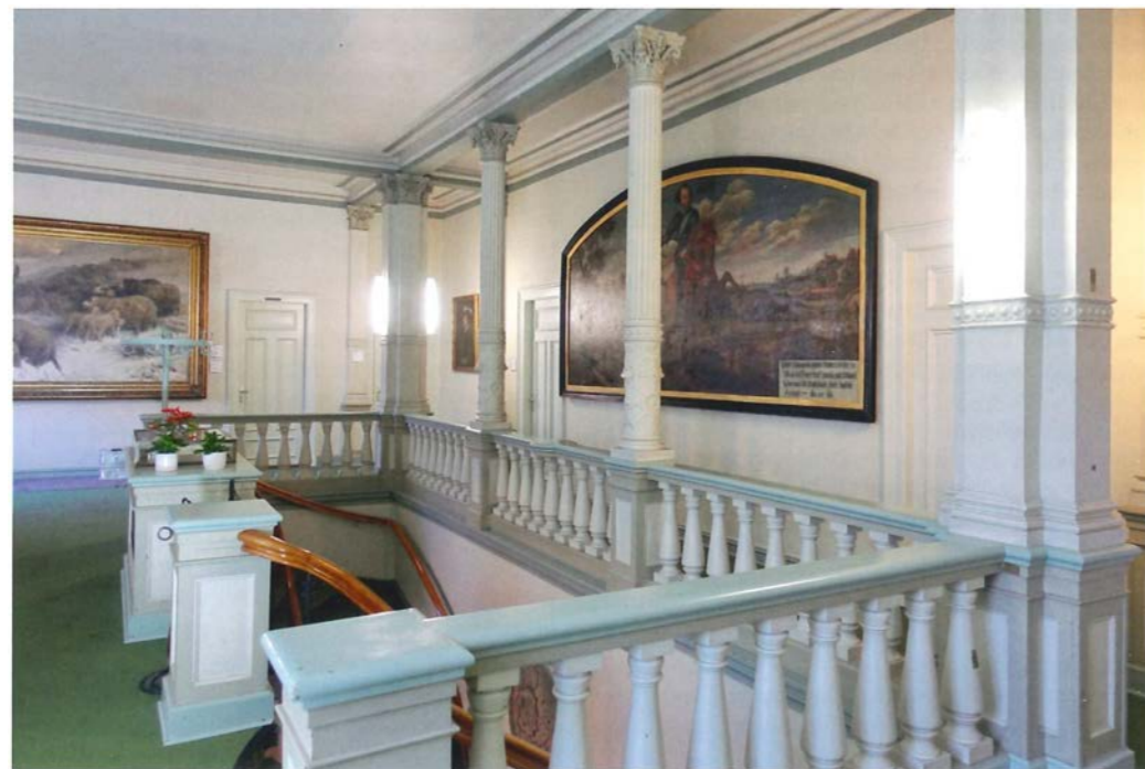
2 Obergeschoss vor der Restaurierung, Aufn. 2017.
